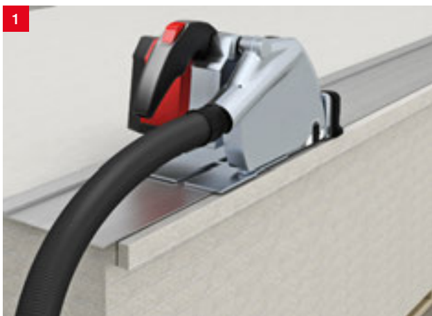
Aestuver® Brandschutzplatten werden mit schienengeführter Handkreissäge zugeschnitten
