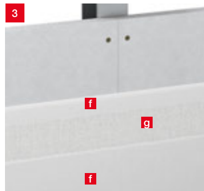
Systemaufbau der Beschichtung mit Spachteltechnik
