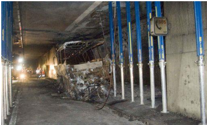
Abbildung 1: Schädigung der Tunneldecke des Gleinalmtunnels nach dem Brand eines Kleinbusses in 2016 [4] (Damage to the tunnel ceiling of the Gleinalmtunnel after the fire of a minibus in 2016)
