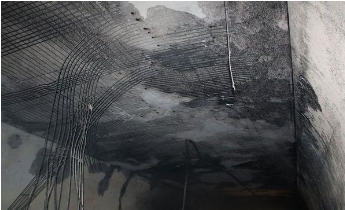
Abbildung 2: Großflächige Betonabplatzungen bis hinter die Bewehrung nach dem Brand eines Autokrans im Gleinalmtunnel in 2018 [7] (Large-scale concrete spalling up to behind the reinforcement after the fire of a mobile crane in the Gleinalm tunnel in 2018)
