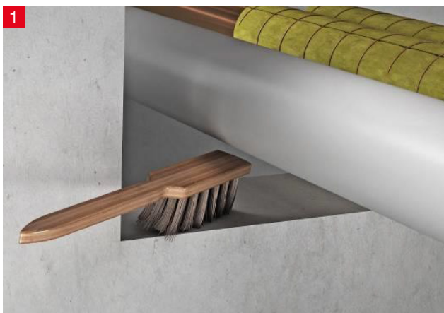
1 Reinigen Sie vor der Montage die Laibung der Bauteilöffnung.
