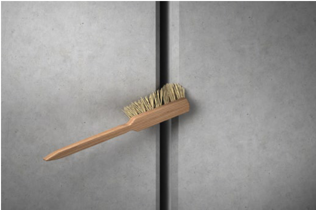
Fugenflanken reinigen
