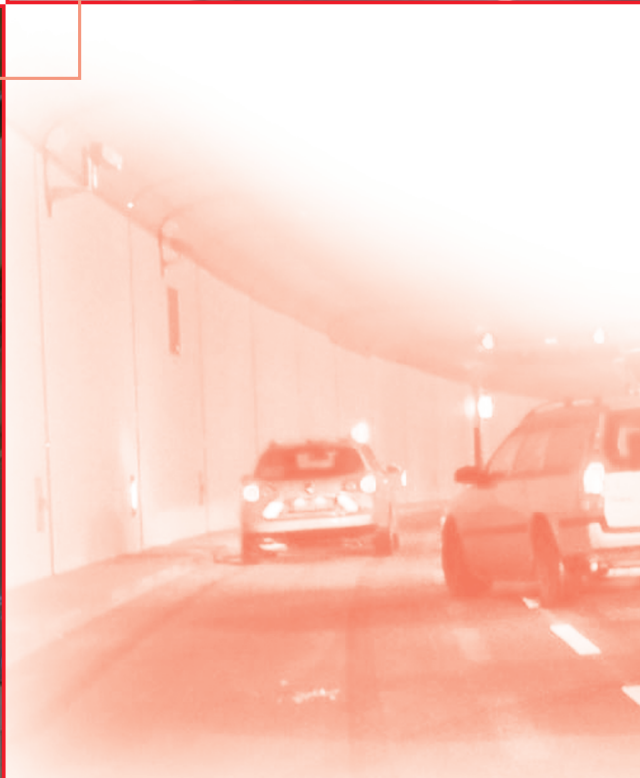
Die Nischenabdeckungen (hier rechts im Bild) bestehen aus einer Schachtwandkonstruktion F 90-A
