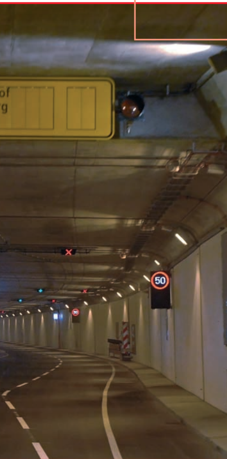
Die Nischenabdeckungen (hier rechts im Bild) bestehen aus einer Schachtwandkonstruktion F 90-A
