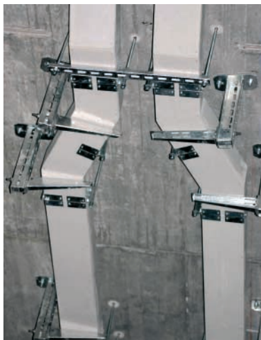
AESTUVER Brand- schutz-Kabelkanäle mit OBO-Abhängungen
