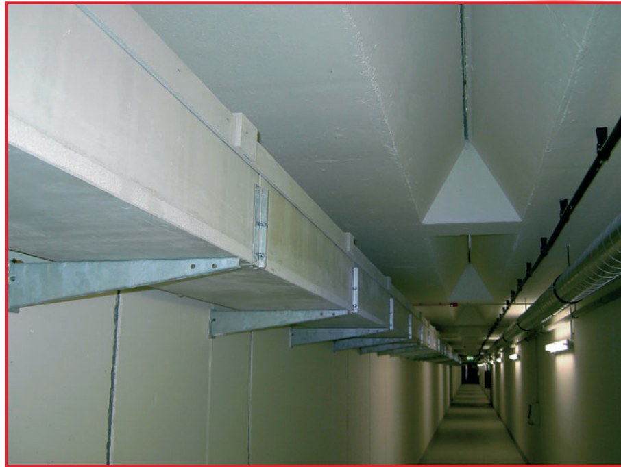
Die Kanalteile wurden lose auf Wandauslegern aufgelegt
